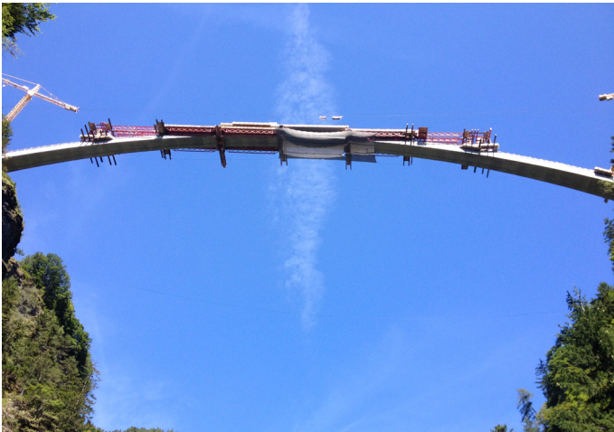
Neue Brücke über der Tamina
